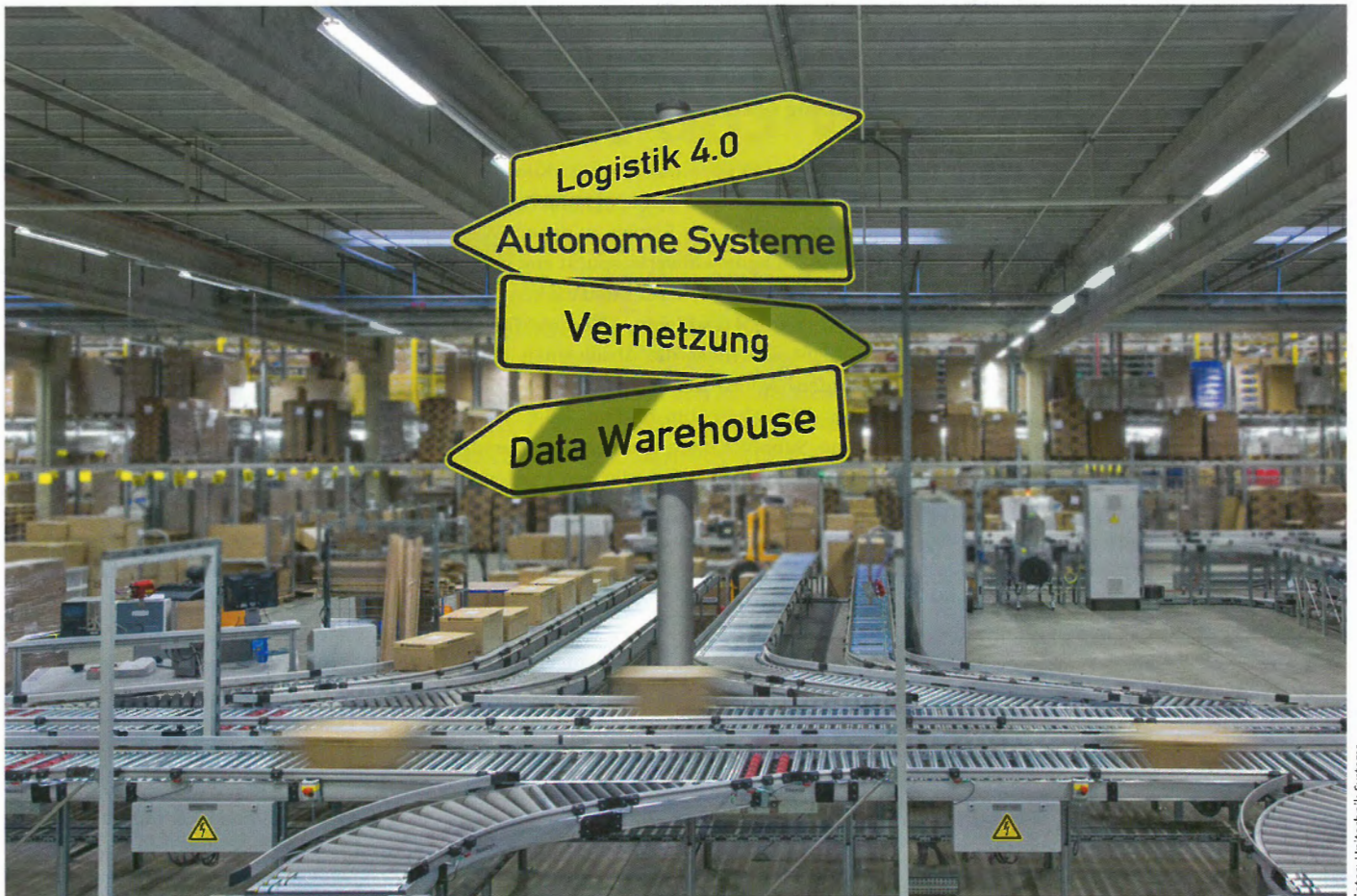
Fotos: Unitechnik Systems
