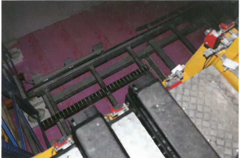
Über der elektrischen Unterfrierschutzheizung wurde eine Bodenisolierung installiert, um die Wärme am Boden zu halten.
