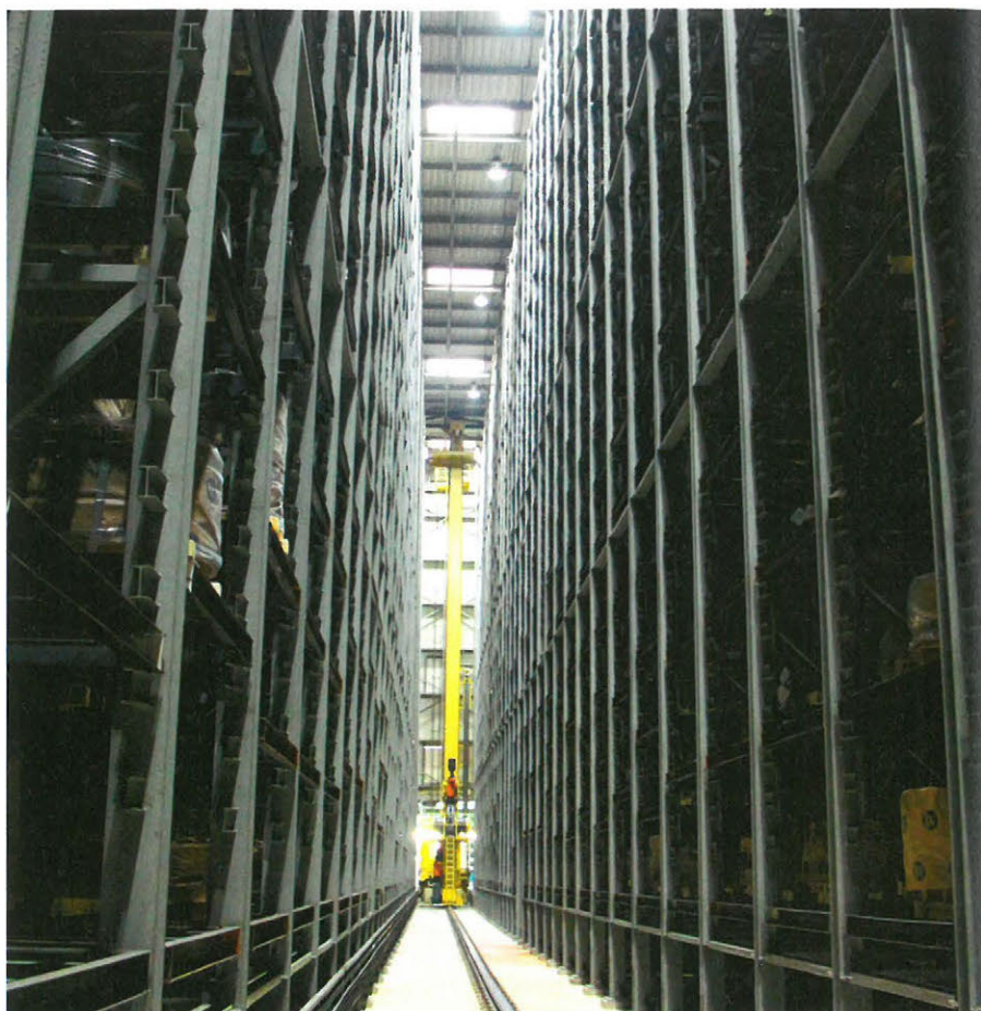
1 Das Versandlager des Bandstahlherstellers Wälzholz wurde einem umfassenden Retrofit unterzogen.
